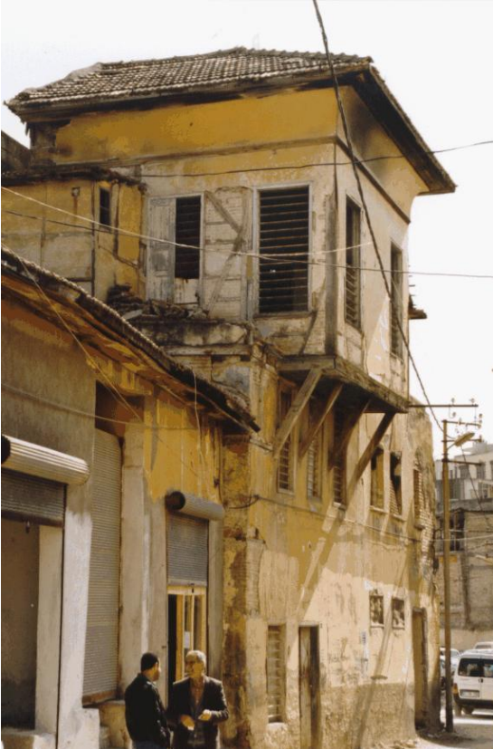
Bina 45 Tescilli (env.no:219) Bina depremden sonra kullanılmamaktadır.
