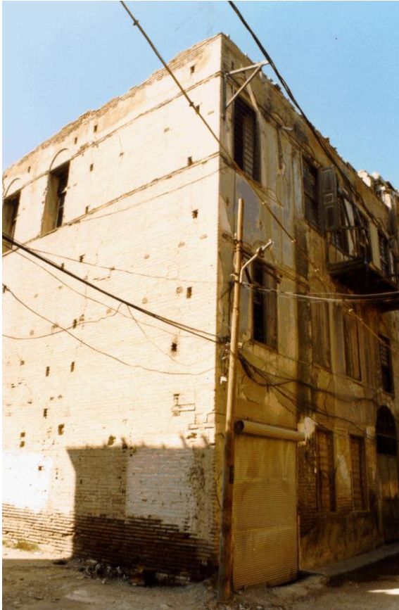
Bina 41 Tescilli (env.no:60) Bina depremden sonra kullanılmamaktadır.
