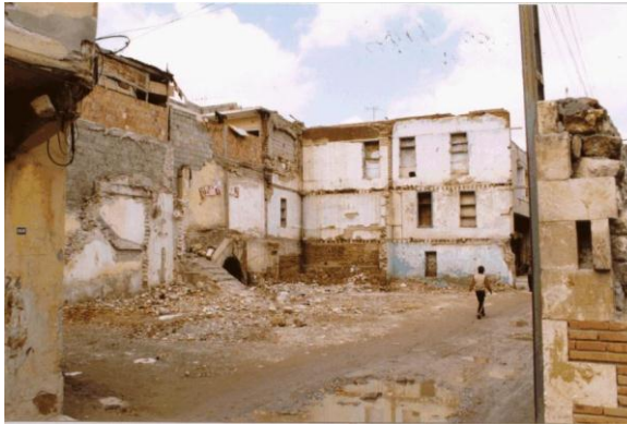
Bina 9 Tescilli (env. no: 147) Deprem sonrası konut kullanılmamaktadır.
