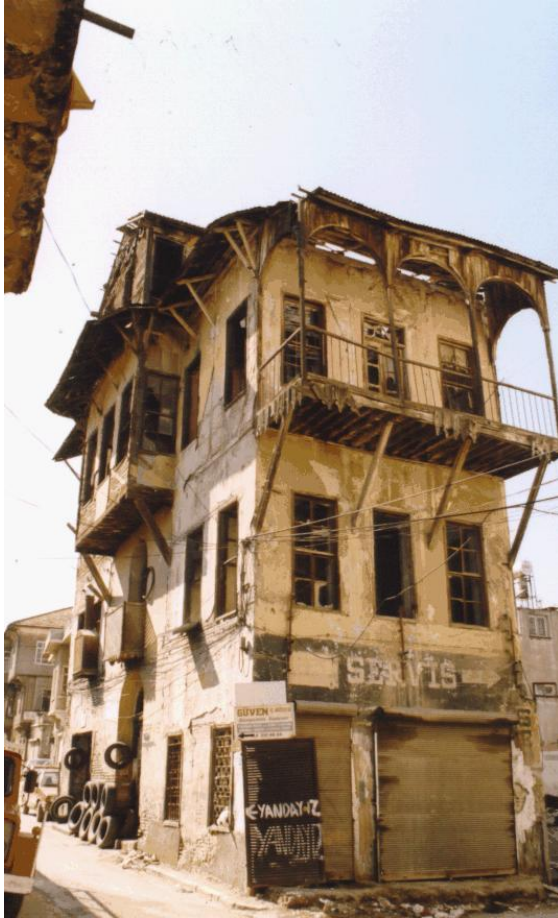
Bina 2 Tescilli (env.no: 123) Deprem sonrası konut kullanılmamaktadır.
