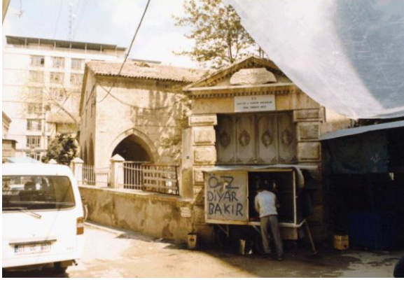
Bina 5 Tescilli (env.no:192) Adana Etnoğrafya Müzesi Yapı kullanılmaktadır.
