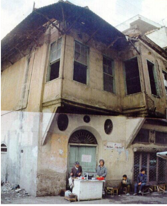
Bina 1 Env.no: 2 Deprem öncesi kaçak yıkım.
