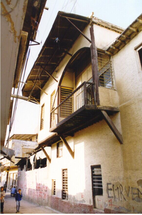
Bina 12 Tescilli (env.no:37) Konut kullanılmamaktadır.
