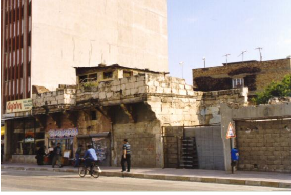
Bina 1 Konut kullanılmamaktadır.
