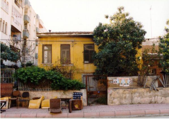
Bina 18 Konut kullanılmamaktadır.
