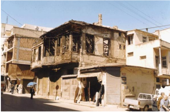
Bina 38 Tescilli (env.no:175) Bina kullanılmamaktadır.
