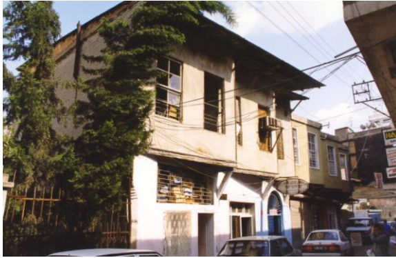
Bina 21 Tescilli (env.no: 1) Deprem sonrası kullanılmamaktadır.
