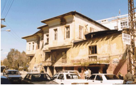
Bina 1 Tescilli (env.no: 155) Deprem sonrası konut kullanılmamaktadır.
