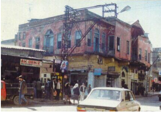
Bina 4 Env.no: 35 Deprem öncesi kaçak yıkım.
