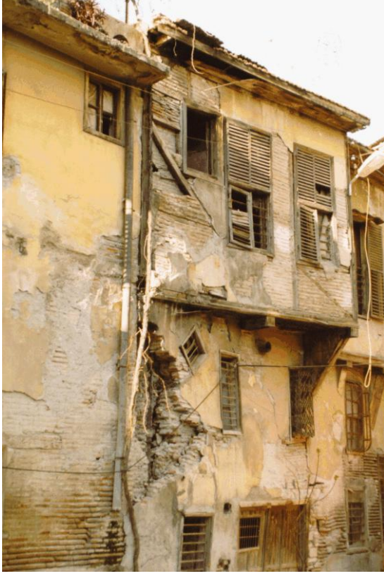
Bina 9 Tescilli (env.no: 106) Deprem sonrası konut kullanılmamaktadır.
