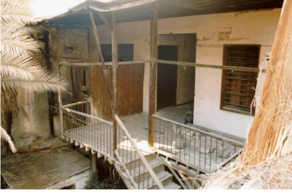
Bina 22 Tescilli (env.no:218) Bina kullanılmamaktadır.
