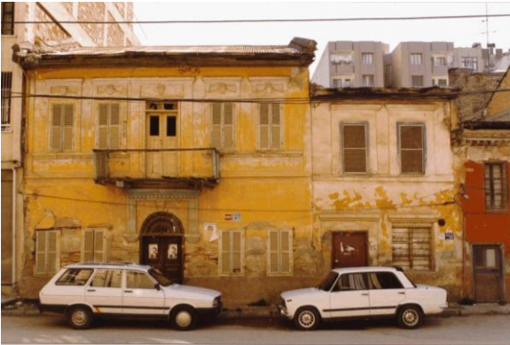
Bina 15 Konut kullanılmamaktadır.
