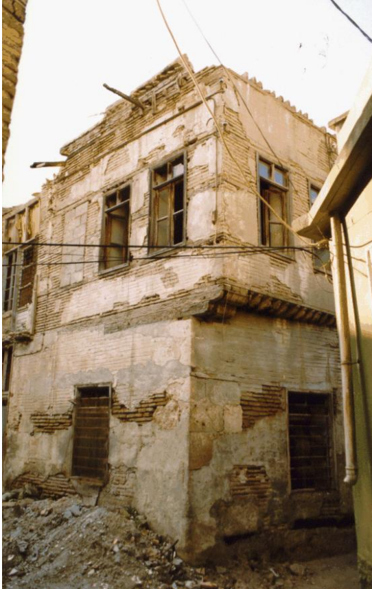
Bina 14 Tescilli (env.no: 105) Deprem sonrası konut kullanılmamaktadır.
