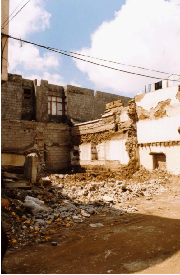
Bina 17 Tescilli (env. no: 139) Deprem sonrası konut yıkılmıştır.
