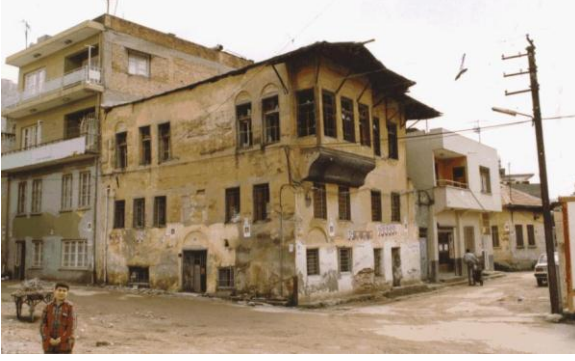
Bina 7 Tescilli (env. no: 148) Deprem sonrası konut kullanılmamaktadır.
