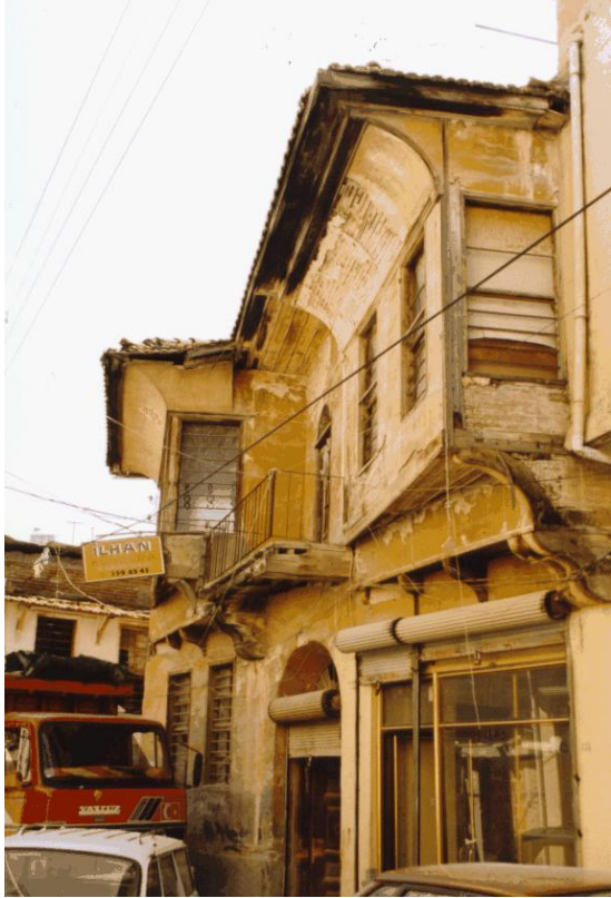
Bina 38 Tescilli (env.no: 133) Deprem sonrası kullanılmamaktadır.
