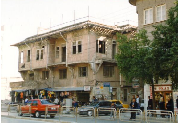
Bina 26 Tescilli (env.no: 90) Deprem sonrası konut kullanılmamaktadır.
