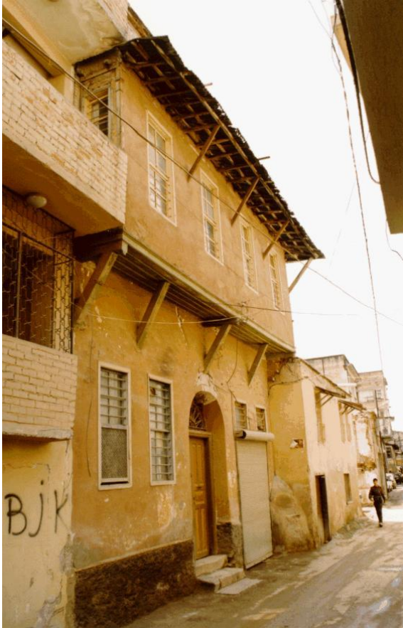
Bina 32 Tescilli (env.no: 211) Konut kullanılmaktadır.
