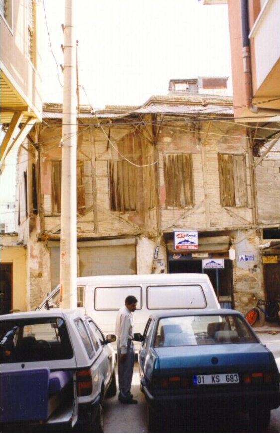
Bina 10 Tescilli (env.no:32) Konut deprem sonrası kullanılmamaktadır.
