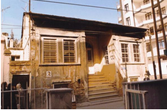
Bina 2 Konut kullanılmamaktadır.
