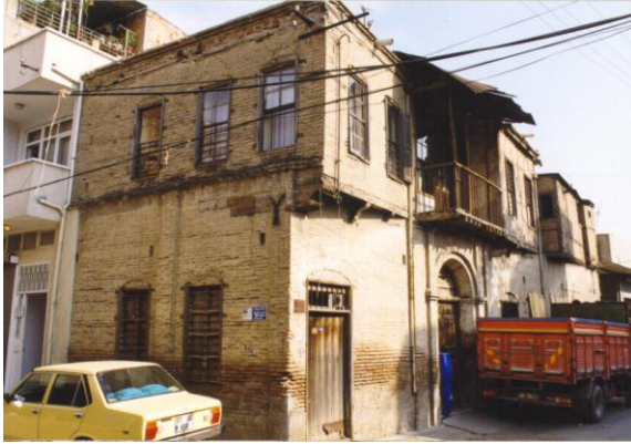
Bina 9 Tescilli (env.no:29) Konut kullanılmaktadır.
