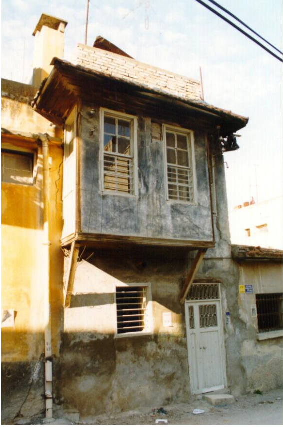
Bina 24 Tescilli (env.no:103) Deprem sonrası konut kullanılmamaktadır.
