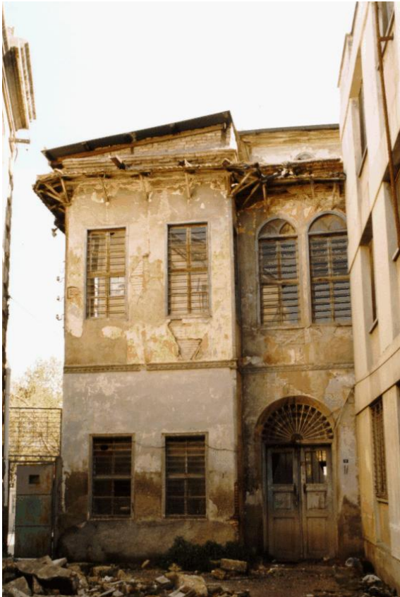
Bina 6 Tescilli (env.no:125) Bina kullanılmamaktadır.
