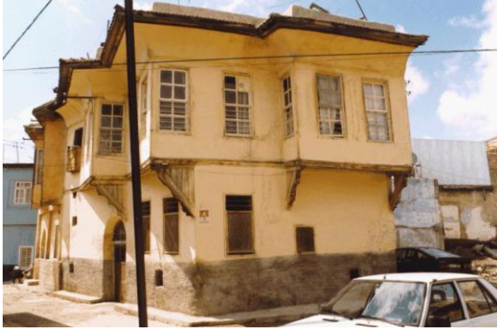
Bina 27 Tescilli (env. no: 128) Konut kullanılmaktadır.
