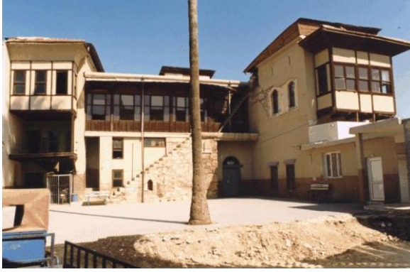
Bina 50 Tescilli (env.no:70) Bina depremden sonra kullanılmamaktadır.
