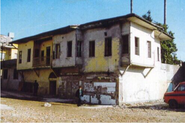
Bina 9 Env.no: 46 Depremden önce kaçak yıkım
