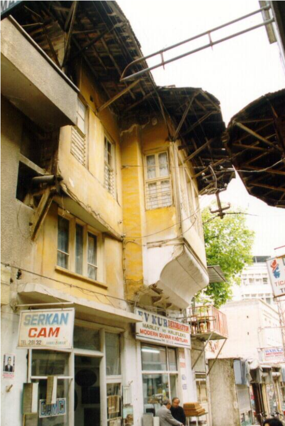
Bina 17 Tescilli (env.no: 9) Deprem sonrası konut kullanılmamaktadır.
