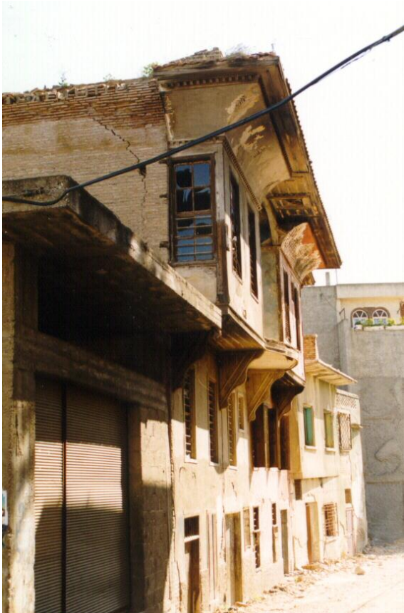
Bina 51 Tescilli (env.no:75-76) Bina depremden sonra kullanılmamaktadır.
