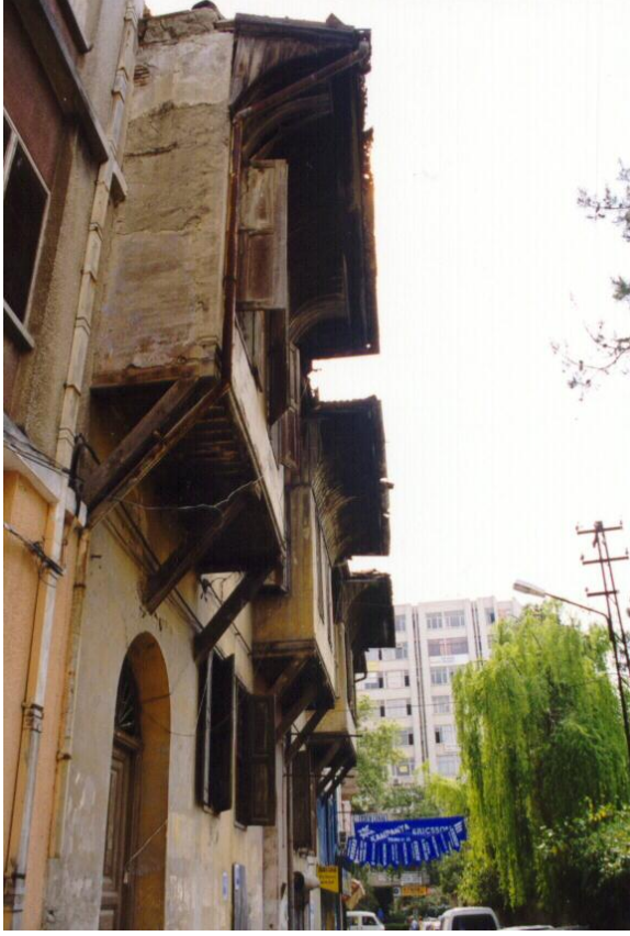
Bina 20 Tescilli (env.no: 3-4-5) Deprem sonrası kullanılmamaktadır.
