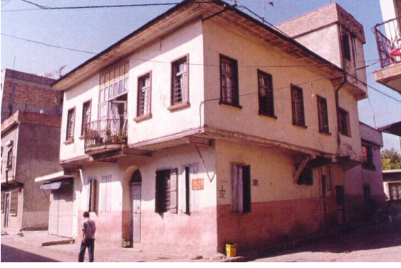
Bina 28 Env.no: 214 Deprem sonrası kaçak yıkım.
