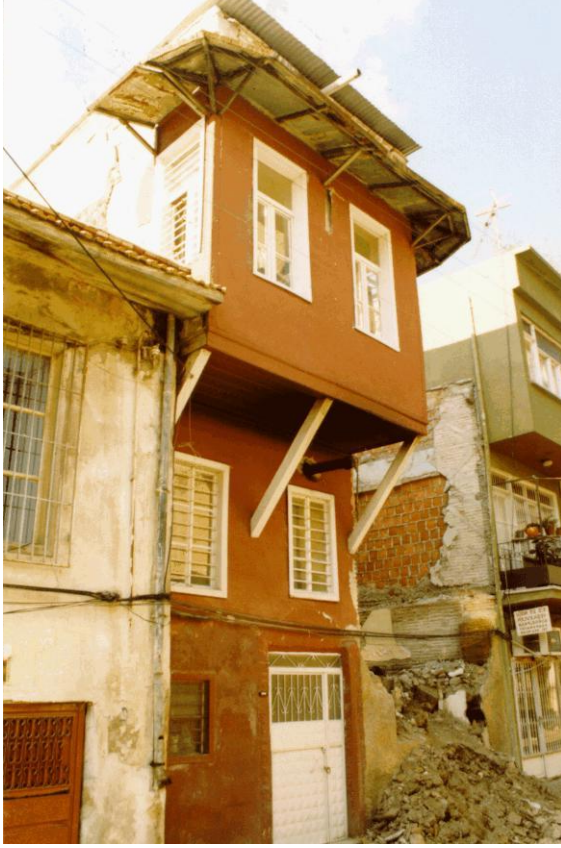
Bina 13 Tescilli (env.no: 108) Deprem sonrası konut kullanılmamaktadır.
