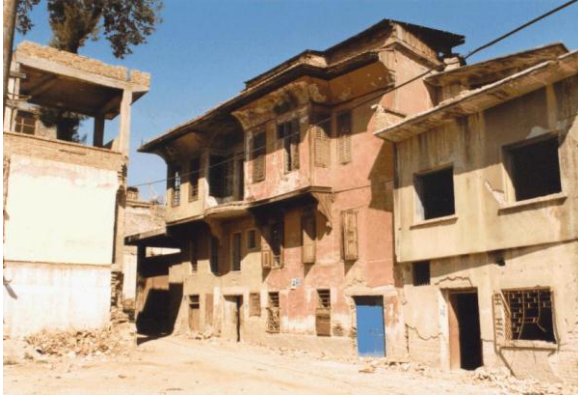
Bina 51 Tescilli (env.no:75-76) Bina depremden sonra kullanılmamaktadır.
