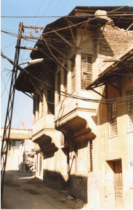
Bina 18 Tescilli (env.no: 67) Konut kullanılmaktadır.
