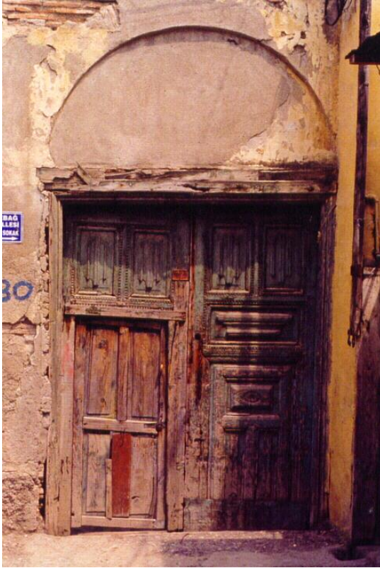
Bina 67 Tescilli (env.no:226) Deprem sonrası bina kullanılmamaktadır.
