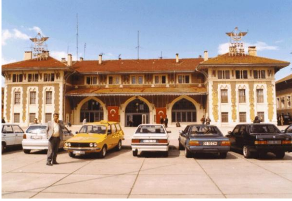
Bina 1 Tescilli (env.no:241) Adana Garı Yapı kullanılmaktadır.
