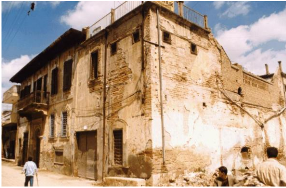
Bina 2 Tescilli (env. no: 39) Deprem sonrası konut kullanılmamaktadır.
