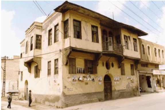
Bina 21 Tescilli (env. no:131) Deprem sonrası konut kullanılmamaktadır.
