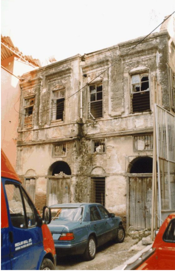
Bina 10-11 Tescilli (env.no: 215-216) Deprem sonrası konut kullanılmamaktadır.
