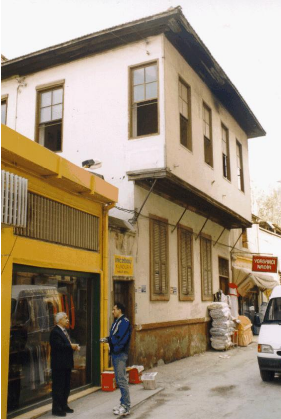
Bina 4 Tescilli (env.no: 26) Konut kullanılmamaktadır.
