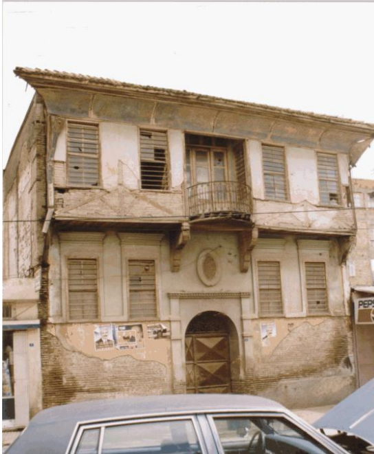
Bina 23 Tescilli (env. no: 152) Deprem sonrası konut kullanılmamaktadır.
