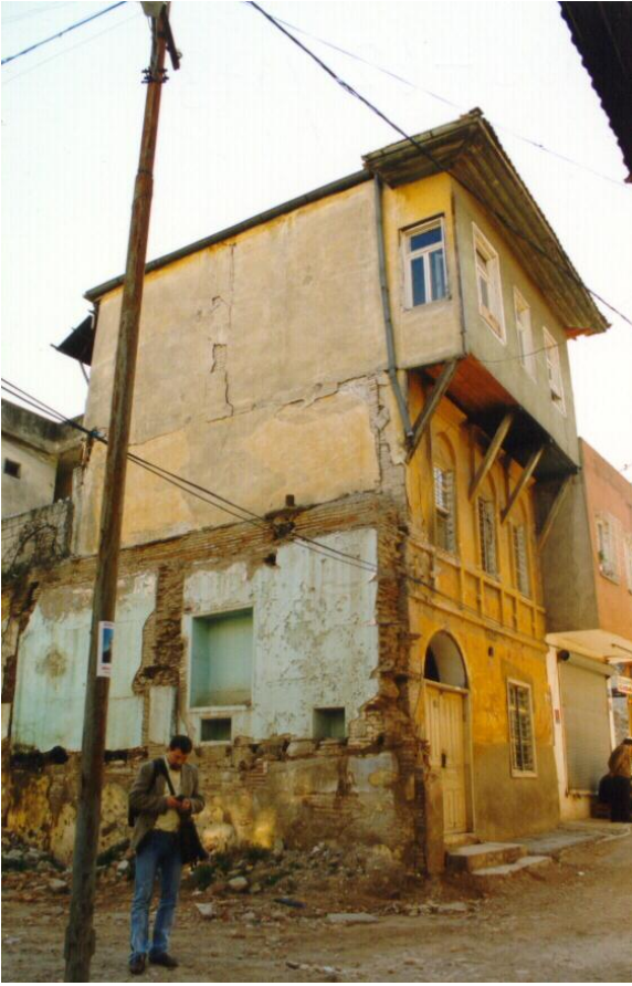
Bina 62 Tescilli (env.no:173) Bina depremden sonra kullanılmamaktadır
