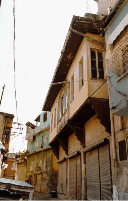
Bina 36 Tescilli (env.no. 140) Konut kullanılmamaktadır.
