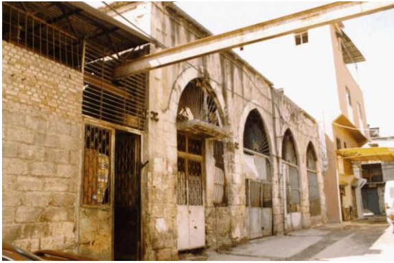
Bina 44 Tescilli (env.no: 170) Deprem sonrası işyeri kullanılmamaktadır.
