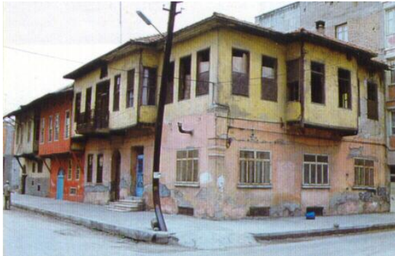
Bina 21 Env.no: 161 Tescil aşamasında yıkım.
