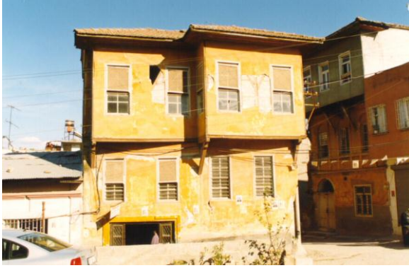
Bina 23 Tescilli (env.no: 95) Deprem sonrası konut kullanılmamaktadır.
