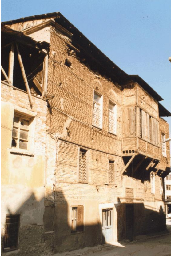
Bina 59 Tescilli (env.no:62) Bina depremden sonra kullanılmamaktadır.
