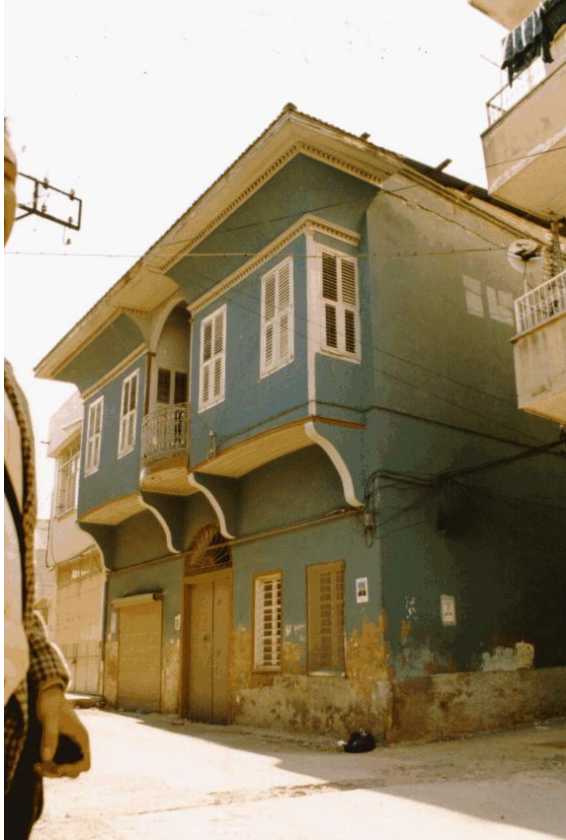
Bina 19 Tescilli (env.no:99) Bina kullanılmamaktadır.
