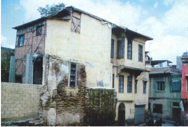
Bina 38 Env.no: 74 Deprem sonrası kaçak yıkım
