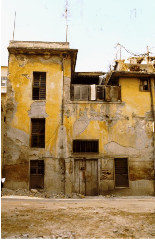
Bina 12 Tescilli (env.no:107) Deprem sonrası konut kullanılmamaktadır.
