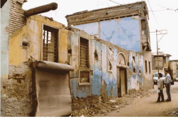
Bina 15 Tescilli (env. no: 136) Deprem sonrası konut yıkılmıştır.
