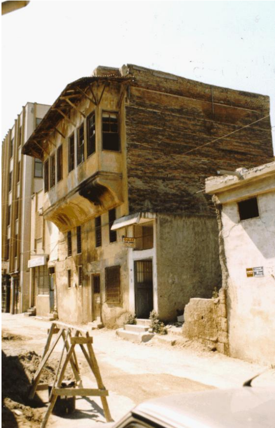
Bina 28 Tescilli (env.no: 121) Bina kullanılmamaktadır.
