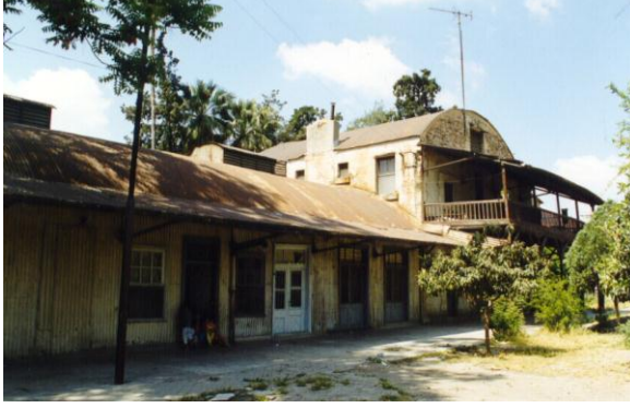
Bina 5 Tescilli (Env.no: 246) Eski İstasyon Binası Yapı kullanılmaktadır.
