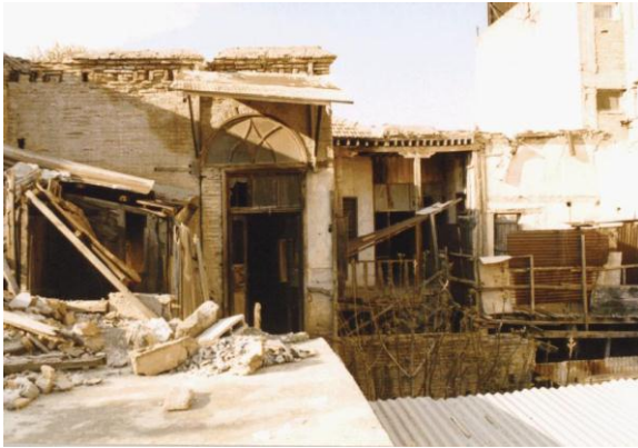
Bina 10-11 Tescilli (env.no: 215-216) Deprem sonrası konut kullanılmamaktadır.
