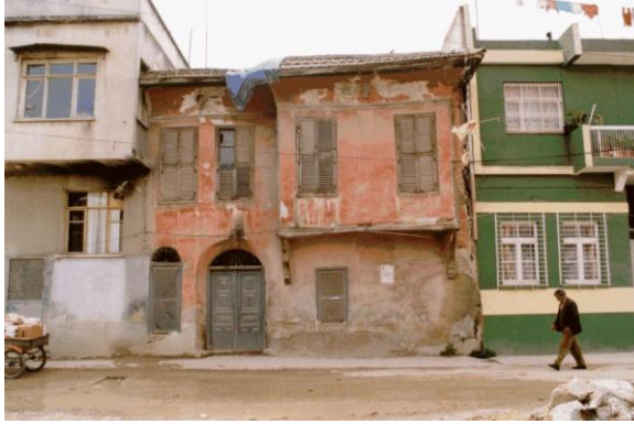
Bina 20 Tescilli (env. no: 132) Deprem sonrası konut kullanılmamaktadır.
