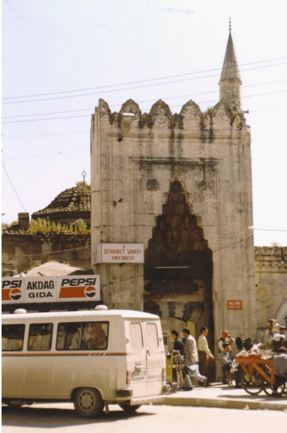
Bina 2 Tescilli (env.no:235) Yağ Cami Vakıflar Gen. Müd. tarafından onarımı yapılmaktadır.
