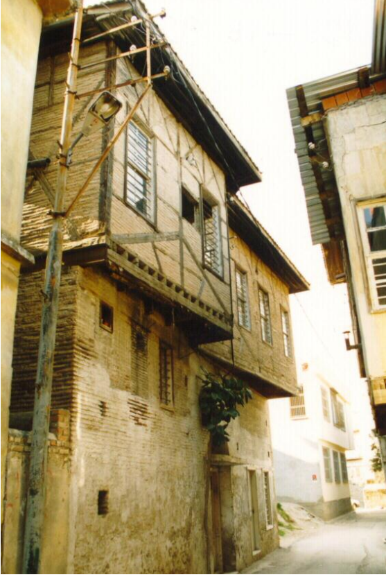
Bina 16 Tescilli (env.no:92) Bina kullanılmamaktadır.
