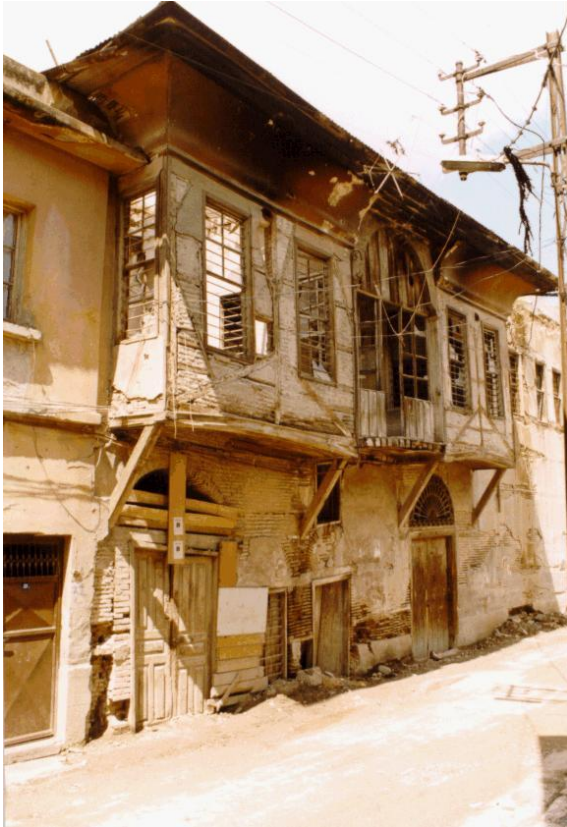
Bina 3 Tescilli (env. no: 150) Deprem sonrası konut kullanılmamaktadır.
