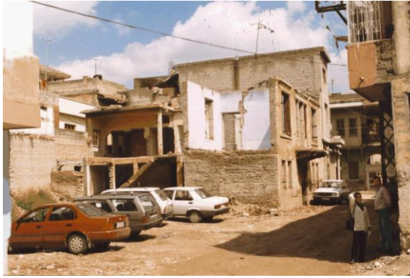
Bina 12-13 Tescilli (env. no: 141-142) Deprem sonrası konutlar kullanılmamaktadır.
