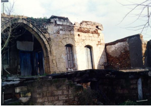
Bina 37 Avlu Cephesi
