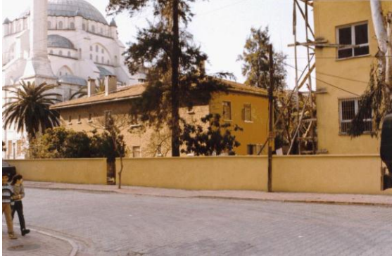
Bina 5 Tescilli (env.no:241) Yapı kullanılmaktadır.
