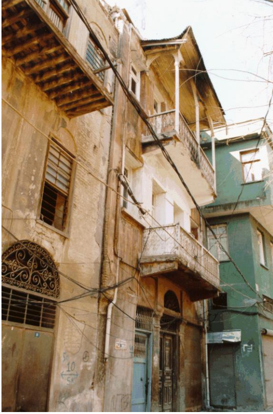
Bina 42 Tescilli (env.no:59) Bina depremden sonra kullanılmamaktadır.
