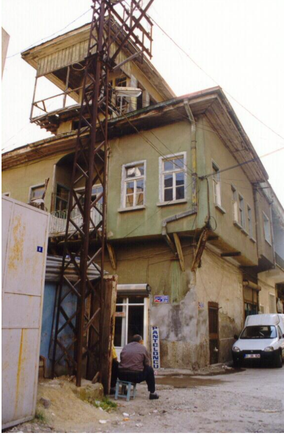
Bina 8 Tescilli (env.no:33) Konut kullanılmamaktadır.
