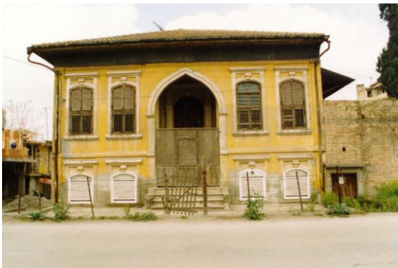
Bina 3 Tescilli (env.no: 160) Konut kullanılmaktadır.
