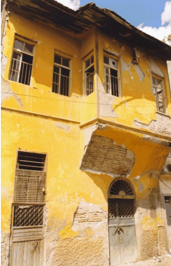
Bina 18 Tescilli (env. no: 138) Deprem sonrası konut kullanılmamaktadır.
