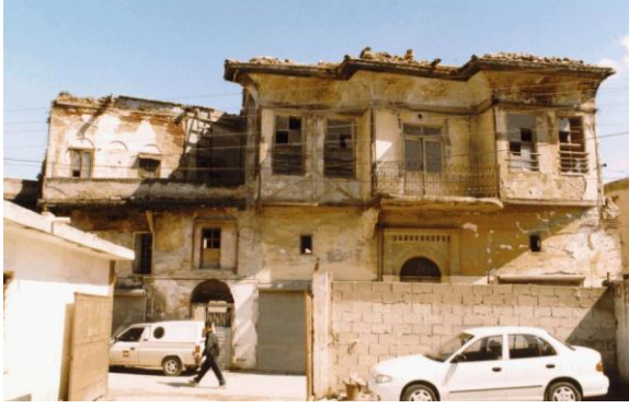
Bina 48 Tescilli (env. no: 44) Deprem sonrası kullanılmamaktadır.
