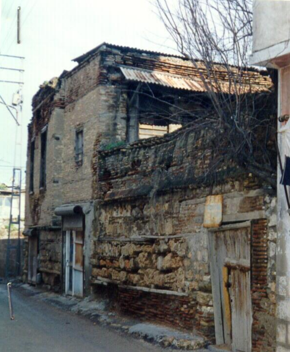
Bina 37 Env.no: 239 Depremden önce kaçak yıkım.
