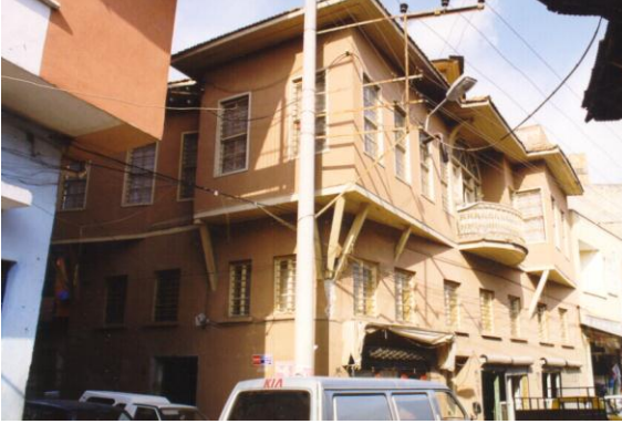
Bina 11 Tescilli (env.no:31) Konut kullanılmaktadır.
