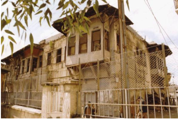
Bina 4 Tescilli (env. no: 149) Deprem sonrası konut kullanılmamaktadır.
