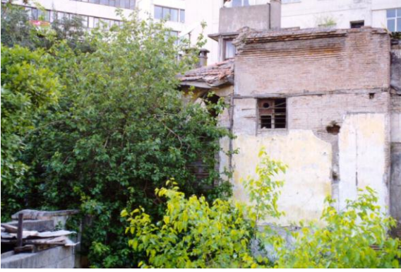
Bina 22 Tescilli (env.no: 23) Deprem sonrası kullanılmamaktadır.
