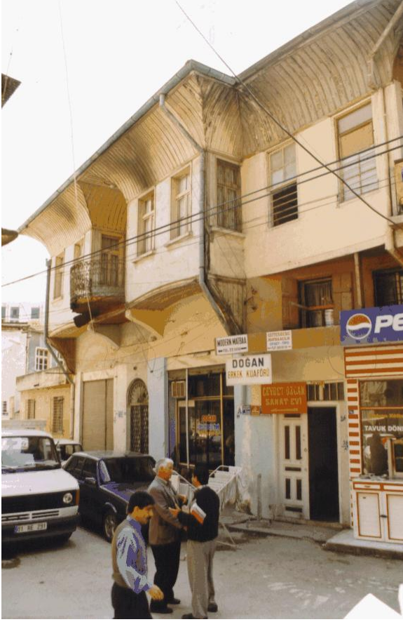
Bina 10 Tescilli (env.no: 17) Konut kullanılmaktadır.
