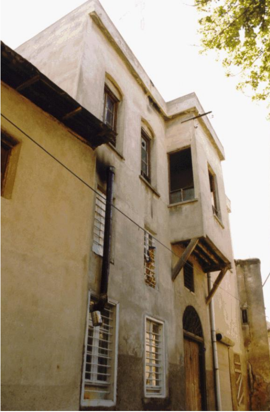
Bina 40 Tescilli (env.no:208) Konut kullanılmamaktadır.
