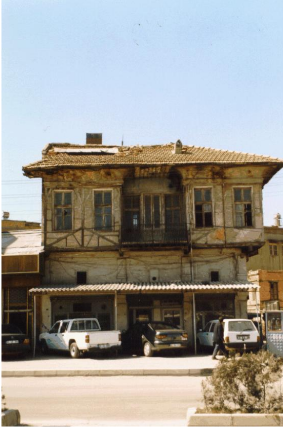
Bina 53 Tescilli (env.no:109) Bina kullanılmamaktadır.
