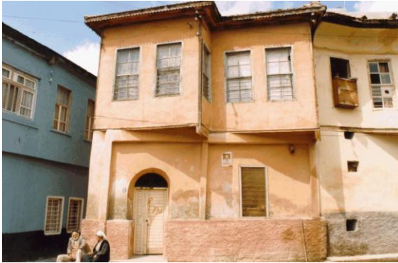
Bina 28 Tescilli (env.no: 129) Konut kullanılmamaktadır.
