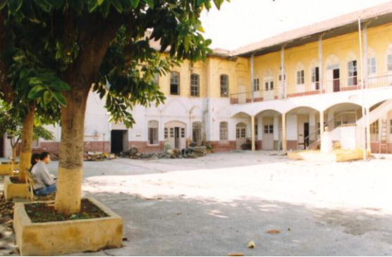
Bina 64 Tescilli (env.no:203) İnkılap İlkokulu Bina depremde sonra kullanılmamaktadır.
