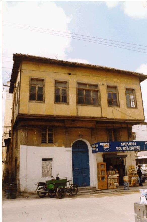
Bina 25 Tescilli (env. no : 154) Deprem sonrası konut kullanılmamaktadır.
