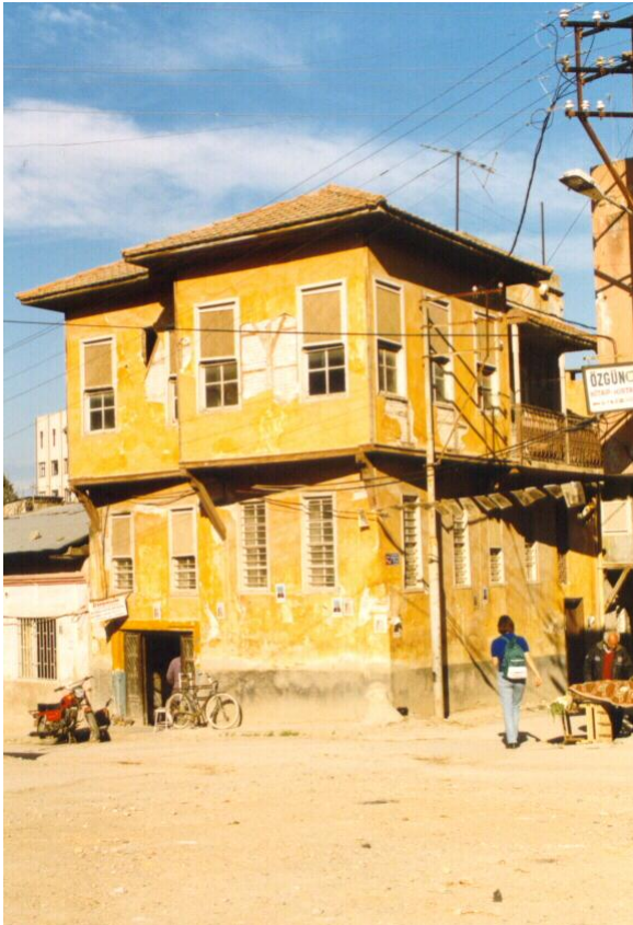
Bina 23 Tescilli (env.no:95) Deprem sonrası konut kullanılmamaktadır.
