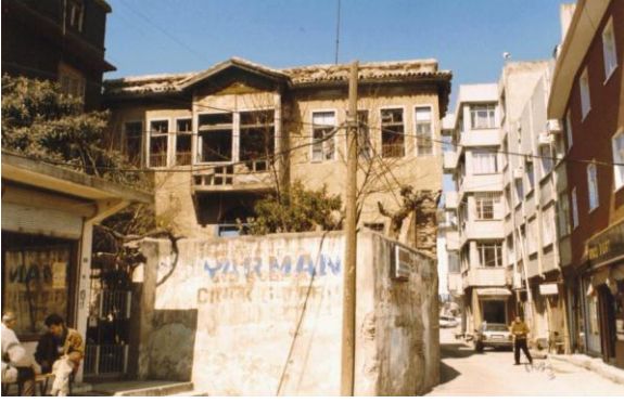
Bina 5 Tescilli (env.no: 119) Deprem sonrası konut kullanılmamaktadır.
