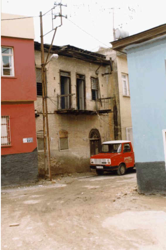
Bina 30 Tescilli (env.no:127) Deprem sonrası kullanılmamaktadır.
