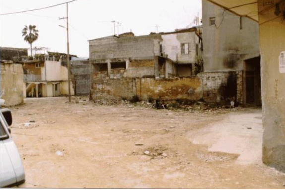
Bina 19 Tescilli (env. no: 206) Deprem sonrası konut yıkılmıştır.
