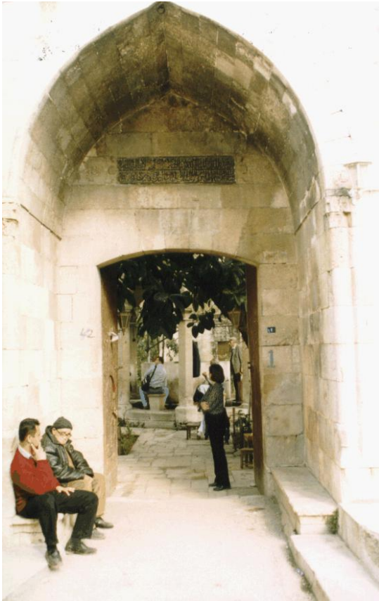
Bina 12 Tescilli (env.no:183) Ulu Cami Medresesi Vakıflar Gen. Müd. tarafından onarımı yapılmaktadır.
