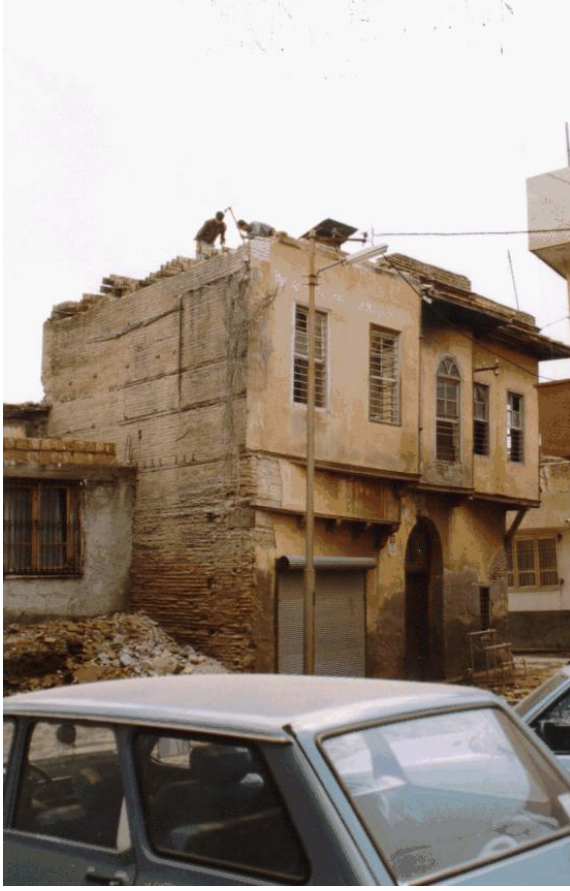
Bina 29 Tescilli (env.no: 130) Depren sonrası kullanılmamaktadır.
