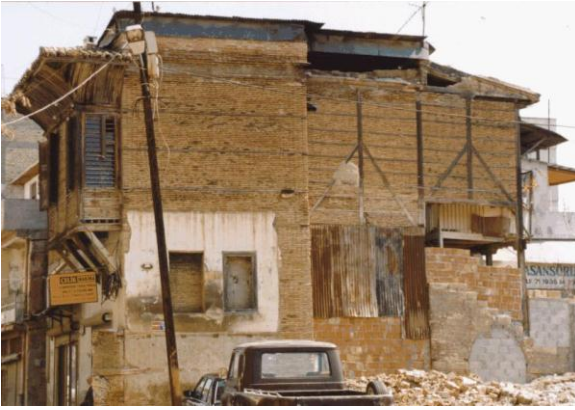
Bina 31 Tescilli (env.no:164) Bina kullanılmamaktadır.
