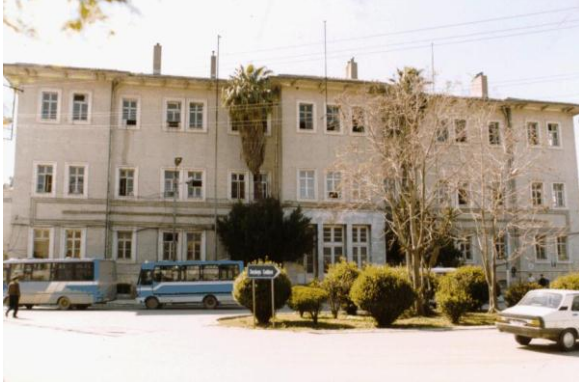
Bina 2 Tescilli (env.no: 198) Eski Adana Valiliği Yapı kullanılmaktadır.
