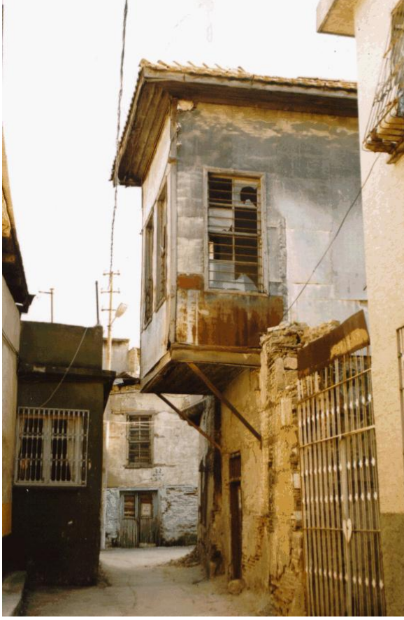
Bina 14 Tescilli (env.no: 105) Deprem sonrası konut kullanılmamaktadır.
