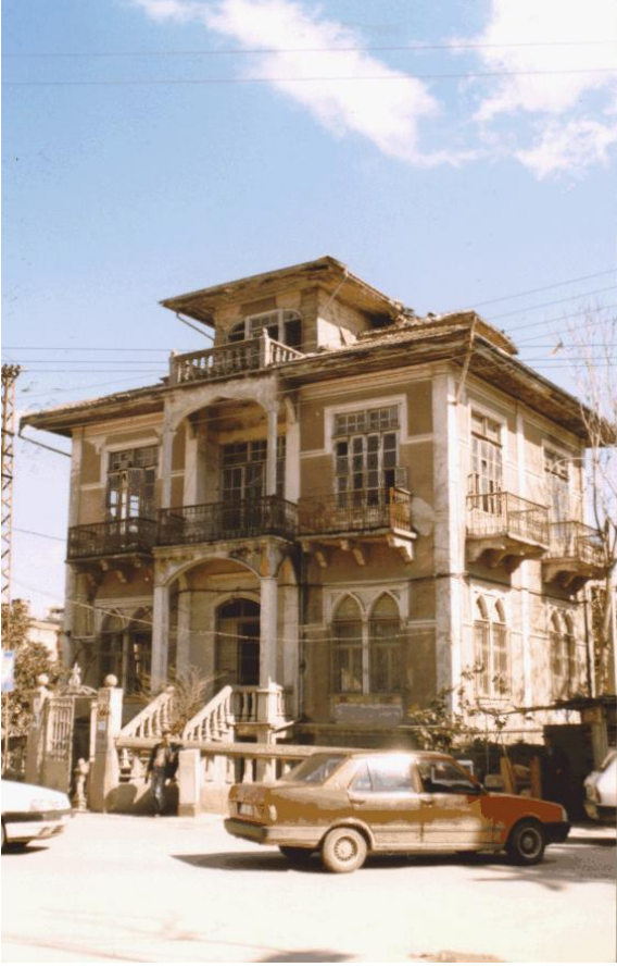
Bina 50 Tescilli (env.no: 162) Deprem sonrası kullanılmamaktadır.
