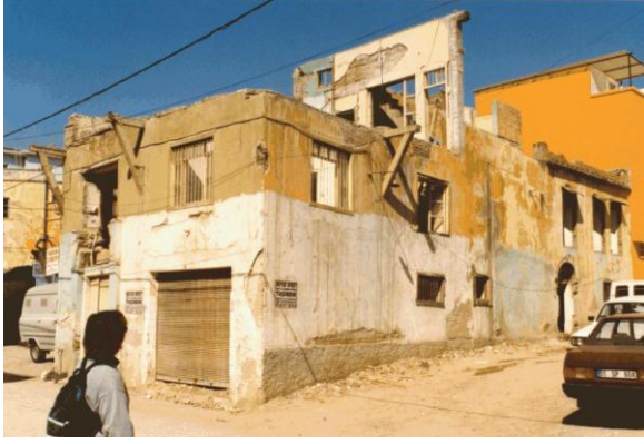
Bina 46 Tescilli (env.no:53) Bina depremden sonra kullanılmamaktadır.
