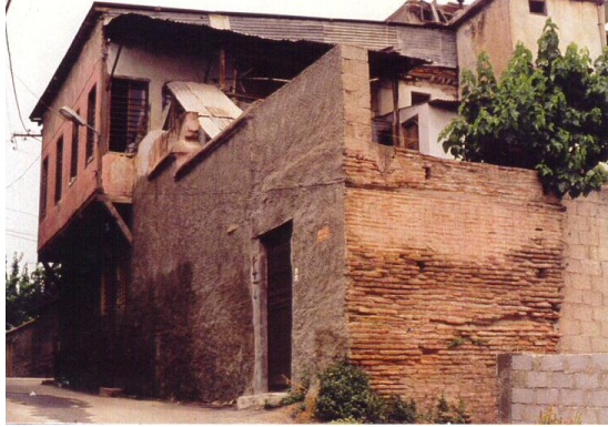
Bina 32 Env.no: 225 Deprem sonrası kurul kararı ile yıkım.
