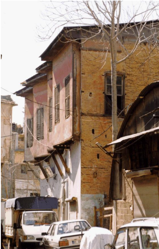
Bina 34 Tescilli (env.no:115) Bina işyeri olark kullanılmaktadır.
