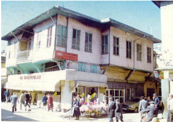
Bina 3 Env.no: 36 Deprem sonrası kaçak yıkım.
