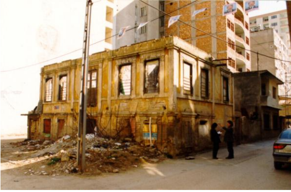
Bina 1 Konut kullanılmamaktadır.
