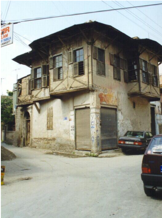
Bina 6 Tescilli (Env.no:168) Yapı konut olarak kullanılmaktadır.
