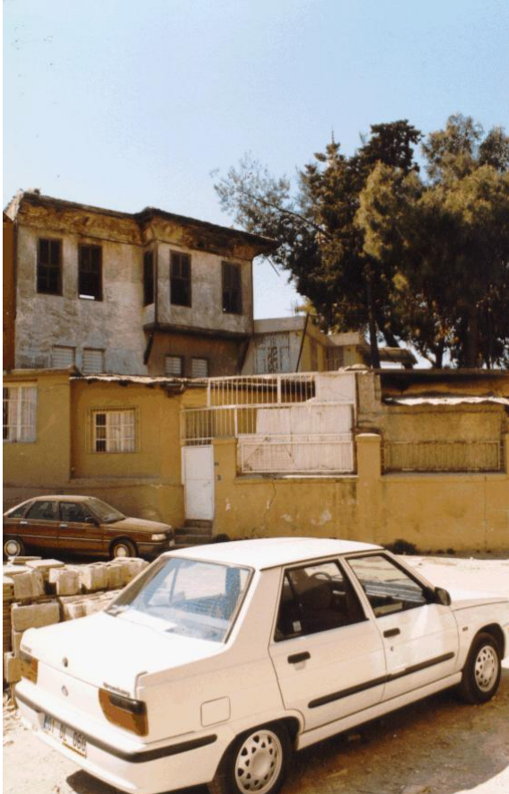
Bina 55 Tescilli (env.no:82) Bina kullanılmamaktadır.
