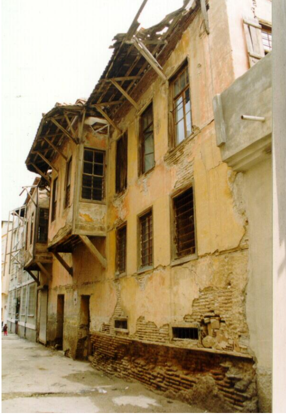
Bina 18 Tescilli (env.no: 8) Deprem sonrası kullanılmamaktadır.
