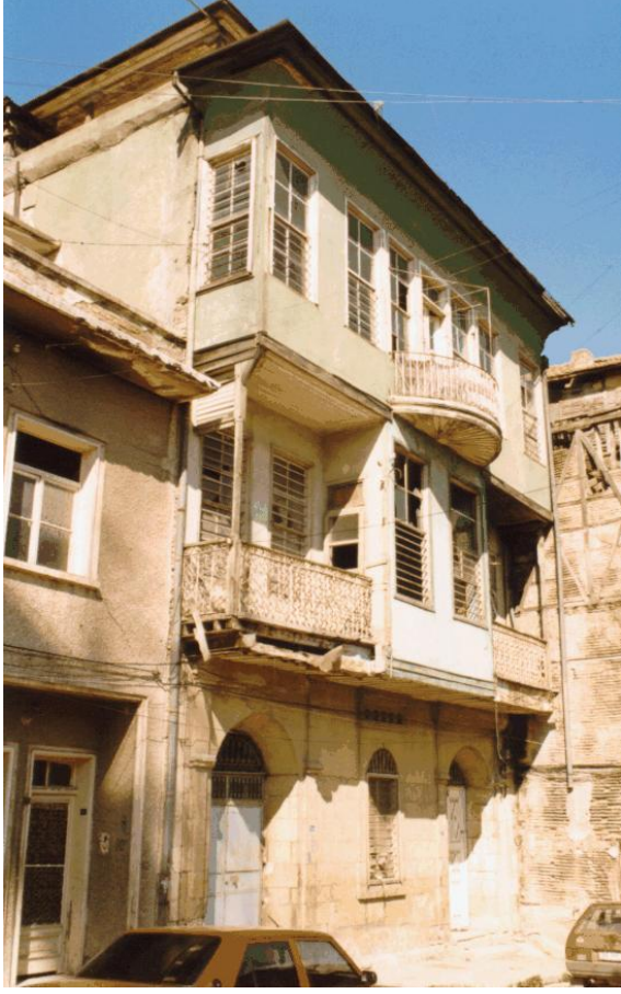
Bina 3 Tescilli (env.no: 122) Deprem sonrası konut kullanılmamaktadır.
