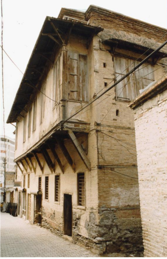
Bina 14 Tescilli (env.no: 22) Deprem sonrası konut kullanılmamaktadır.
