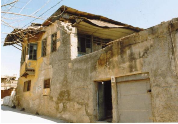
Bina 47 Tescilli (env.no:54) Bina depremden sonra kullanılmamaktadır.
