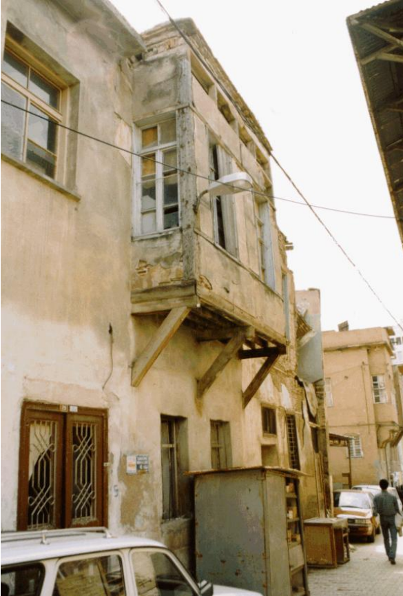
Bina 15 Tescilli (env.no: 24) Deprem sonrası konut kullanılmamaktadır.
