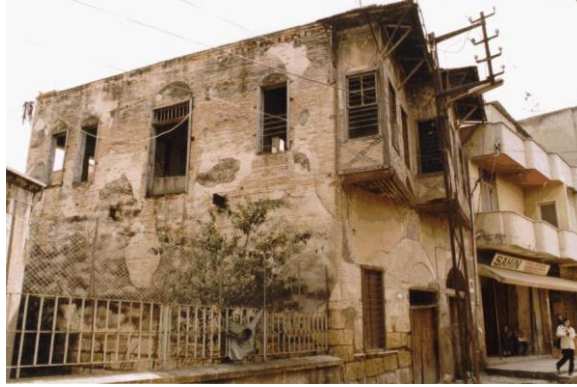
Bina 5 Tescilli (env. no: 151) Deprem sonrası konut kullanılmamaktadır.
