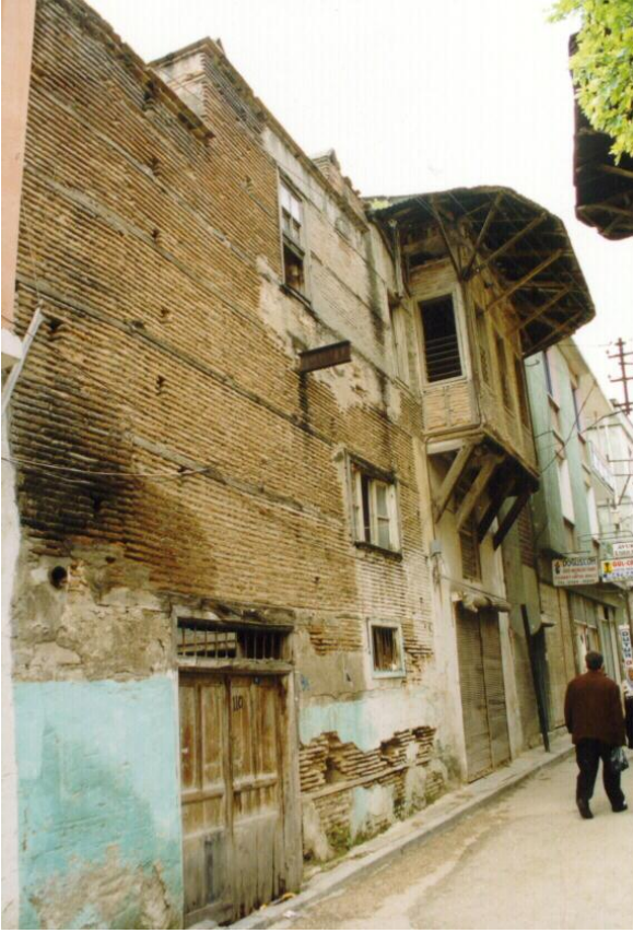
Bina 16 Tescilli (env.no: 10) Deprem sonrası konut kullanılmamaktadır.
