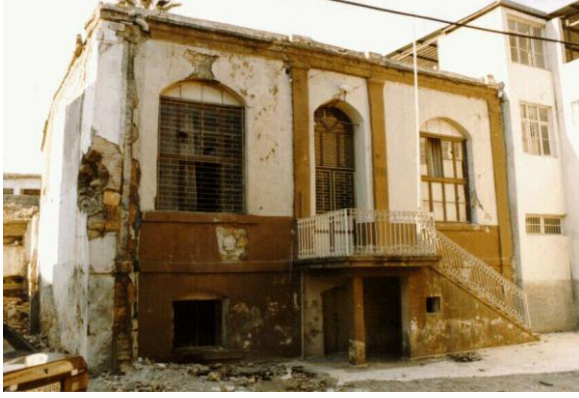
Bina 18 M.E.B. İzci Evi Bina kullanılmamaktadır.
