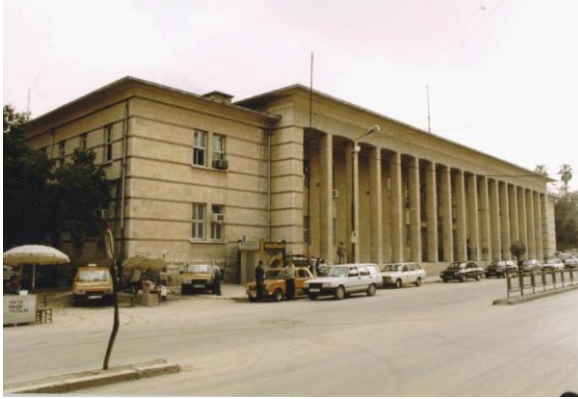
Bina 7 Tescilli Adana Adliyesi (env.no: 240) Yapı kullanılmaktadır.
