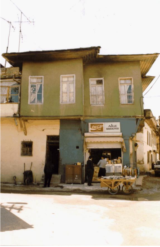
Bina 35 Tescilli (env.no: 210) Konut kullanılmaktadır.
