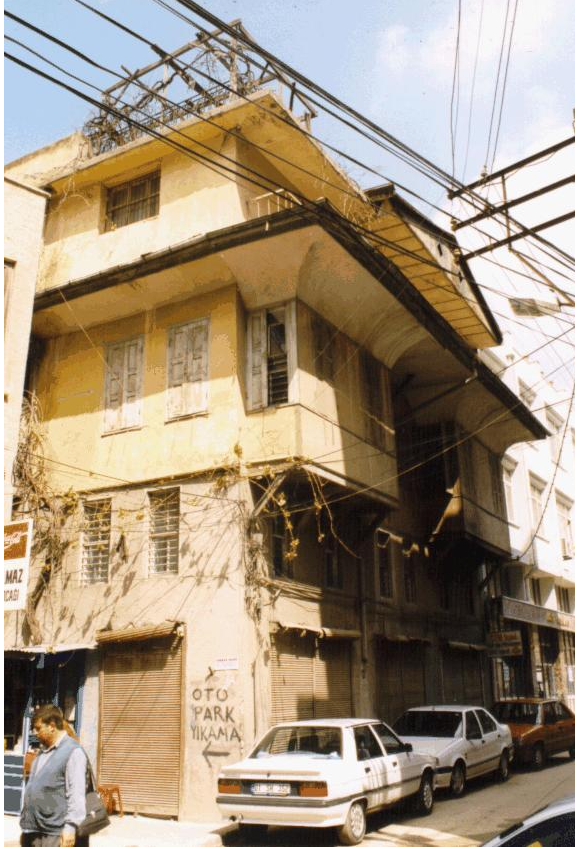
Bina 2 Tescilli (env.no: 12) Bina kullanılmamaktadır.
