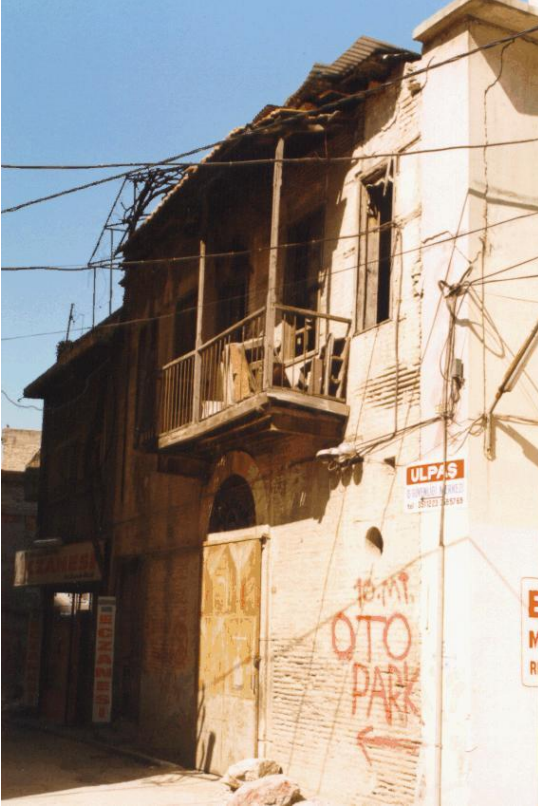
Bina 44 Tescilli (env.no:220) Bina depremden sonra kullanılmamaktadır.
