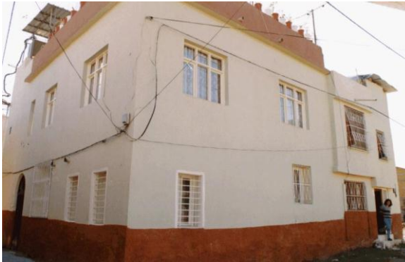
Bina 49 Tescilli (env.no: 158) Konut kullanılmaktadır.
