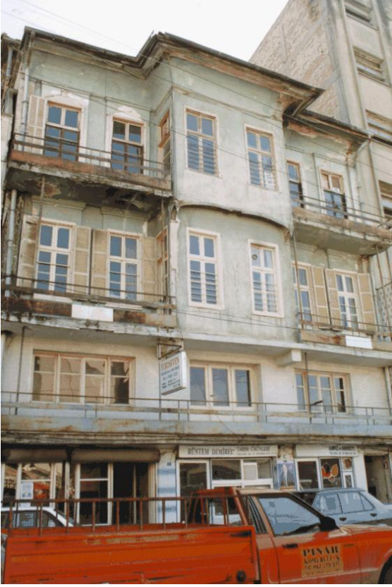
Bina 7 Tescilli (env.no:126) Bina kullanılmamaktadır.
