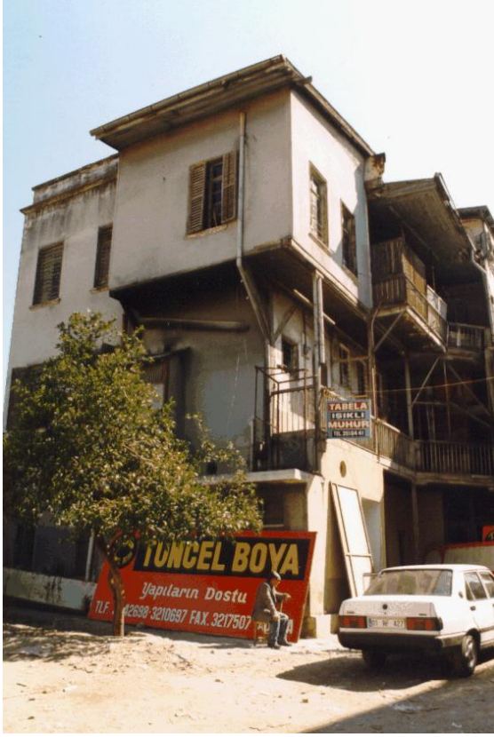
Bina 40 Tescilli (env.no:221) Bina depremden sonra kullanılmamaktadır.
