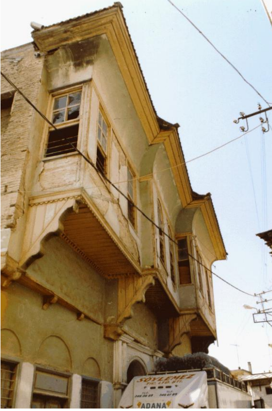
Bina 29 Tescilli (env.no:116) Bina kullanılmamaktadır.
