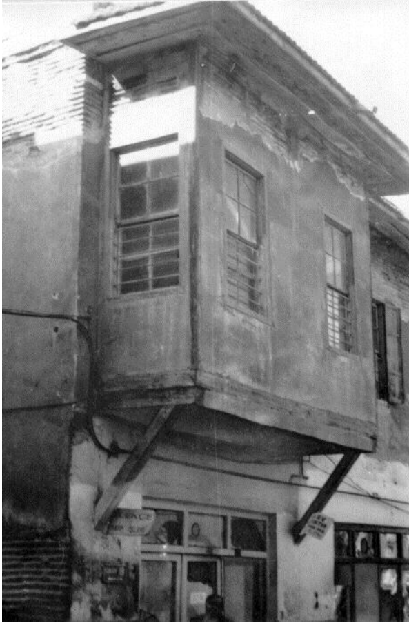
Bina 35 Env.no: 86 Depremden önce kaçak yıkım.
