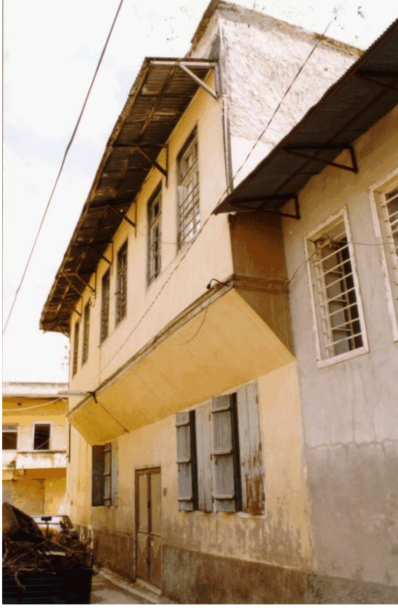
Bina 31 Tescilli (env.no: 212) Konut kullanılmaktadır.
