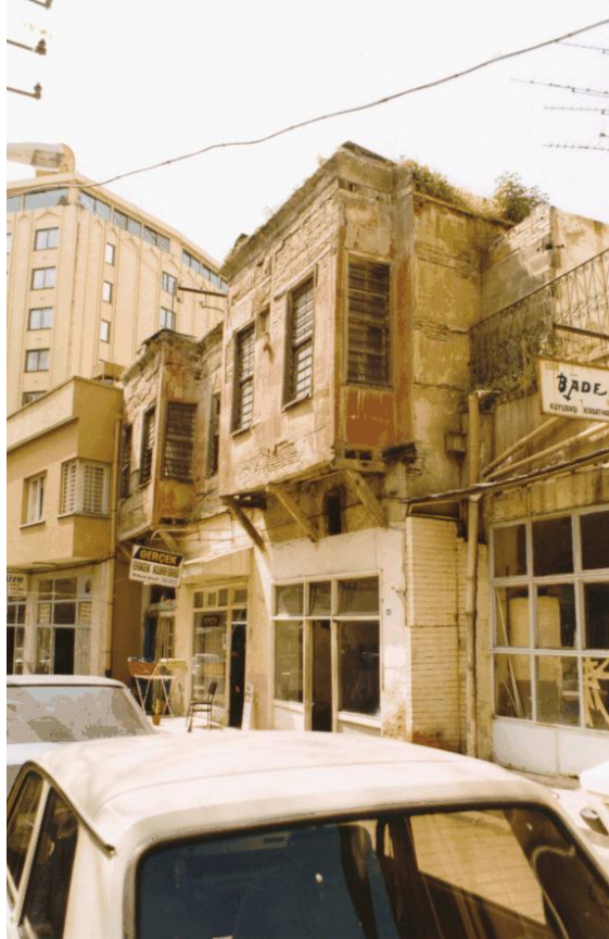
Bina 7 Tescilli (env.no: 27) Yapı işyeri olarak kullanılmaktadır.
