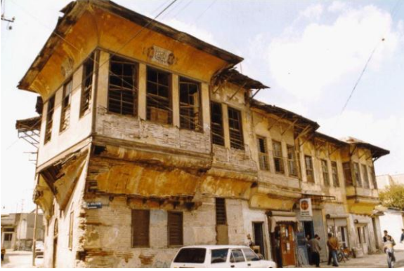
Bina 10-11 Tescilli (env. no: 145-146) Deprem sonrası konutlar kullanılmamaktadır.
