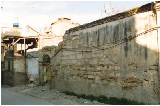
Bina 25 Tescilli (env.no: 94) Deprem sonrası konut yıkılmıştır.
