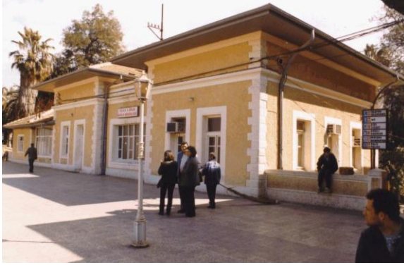
Bina 2 Tescilli (env.no:241) Sağlık Müdürlüğü (T.C.D.D.) Yapı kullanılmaktadır.
