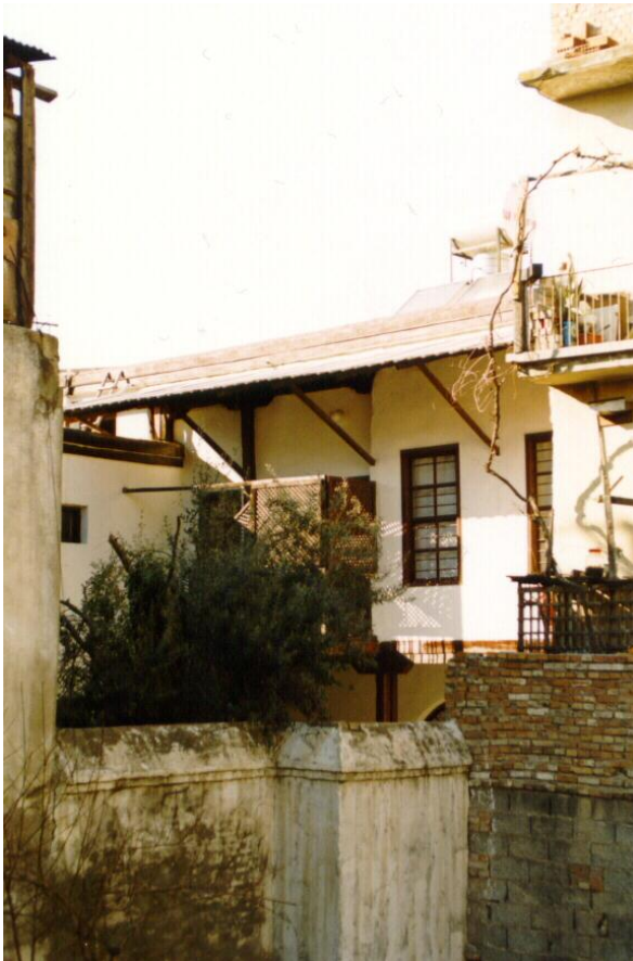
Bina 15 Tescilli (env.no:91) Konut kullanılmaktadır.
