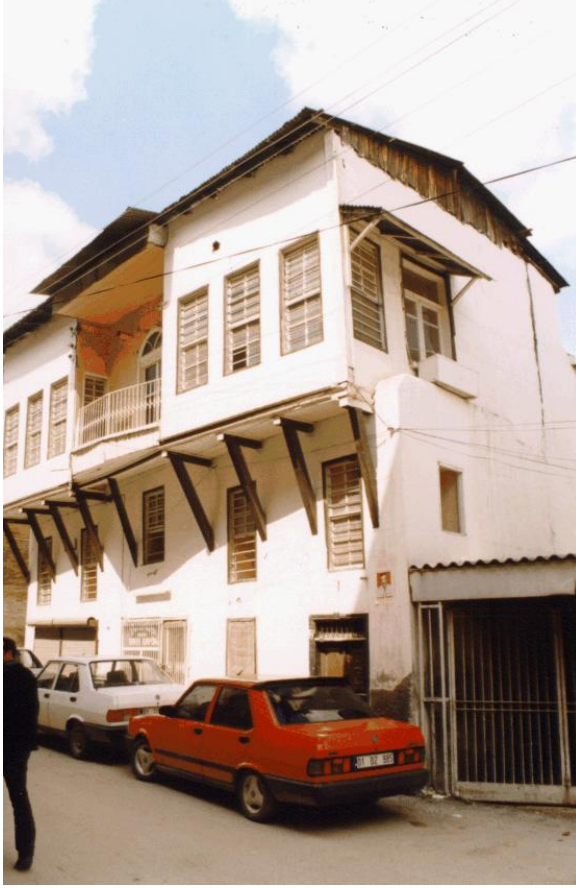
Bina 24 Tescilli (env. no: 157) Konut kullanılmamaktadır.
