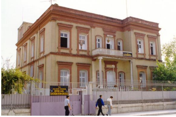
Bina 3 Tescilli (Env. no: 243) İstiklal İlköğretim Okulu Yapı kullanılmaktadır.
