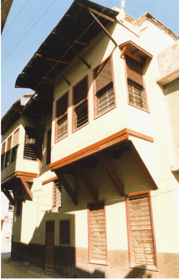
Bina 21 Tescilli (env.no: 65) Konut kullanılmaktadır.
