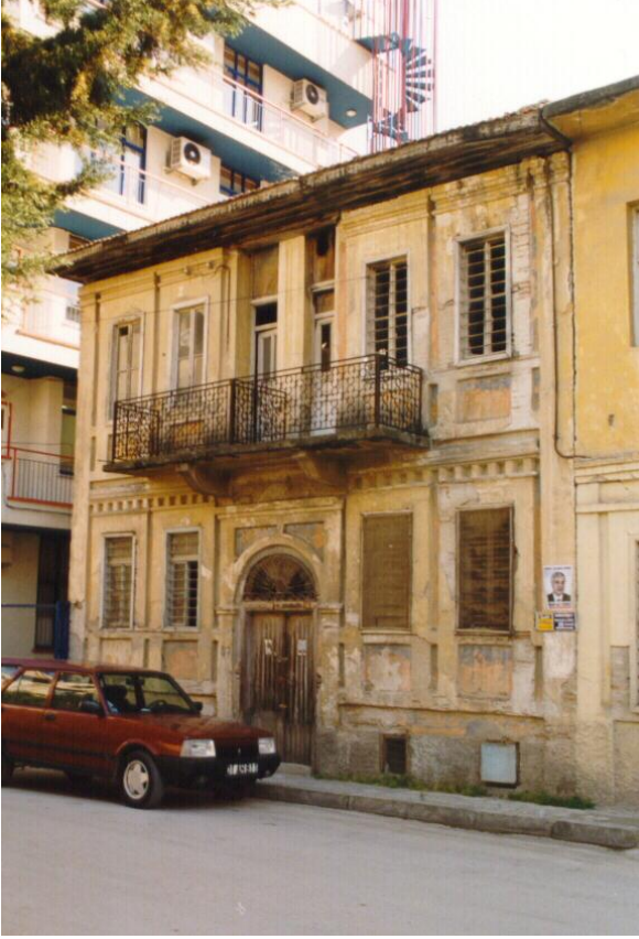
Bina 14 Konut kullanılmamaktadır.
