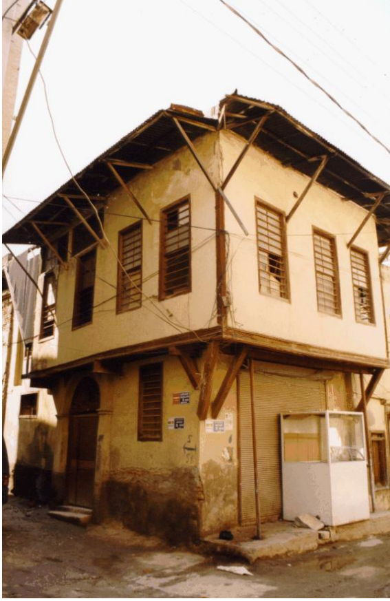
Bina 41 Tescilli (env.no:207) Deprem sonrası işyeri kullanılmamaktadır.
