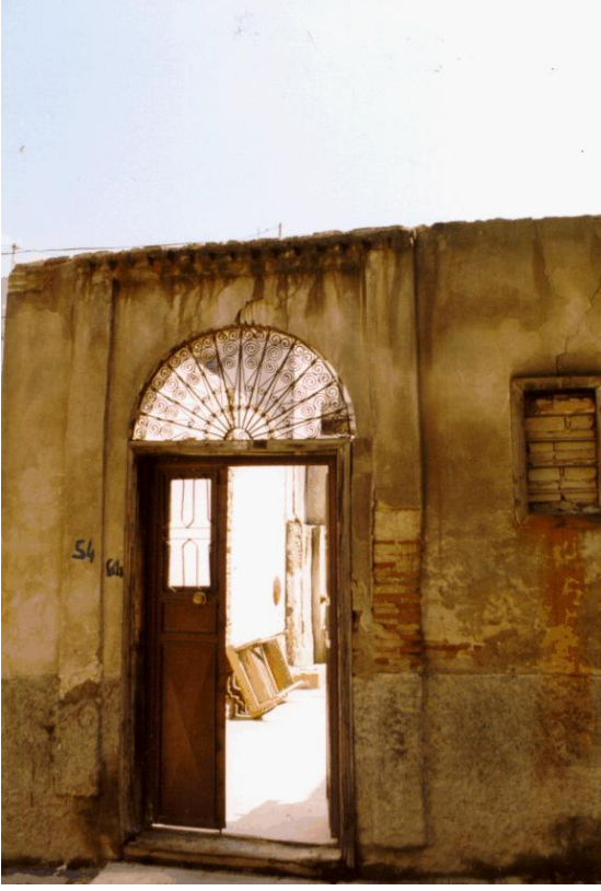
Bina 37 Tescilli (env.no: 209) Deprem sonrası yıkılmıştır.
