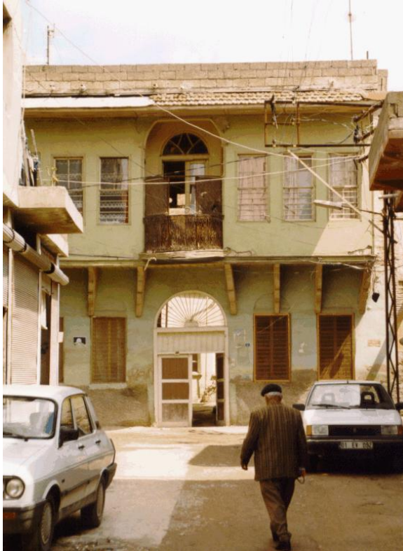
Bina 14 Tescilli (env. no: 137) Deprem sonrası konut kullanılmamaktadır.
