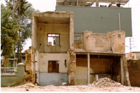
Bina 1 Tescilli (env. no: 40) Deprem sonrası konut yıkılmıştır.
