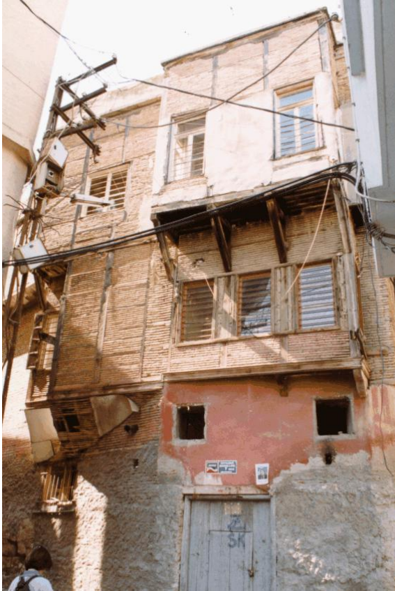
Bina 26 Tescilli (env.no:79) Bina kullanılmamaktadır.
