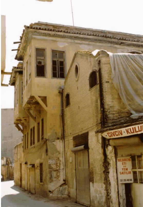
Bina 5 Tescilli (env.no: 119) Deprem sonrası konut kullanılmamaktadır.
