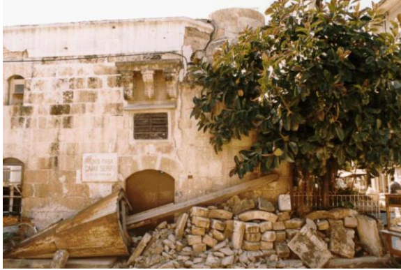
Bina 33 Tescilli (env.no:231) Memiş Paşa Cami Deprem sonrası cami kullanılmamaktadır.
