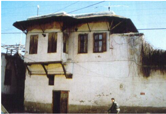
Bina 33 Env.no: 42 Deprem sonrası kaçak ile yıkım.
