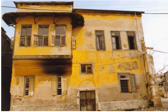
Bina 14 Tescilli (env.no:98) Bina kullanılmamaktadır.
