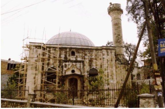
Bina 22 Mestanzade Cami Deprem sonrası kullanılmamaktadır.
