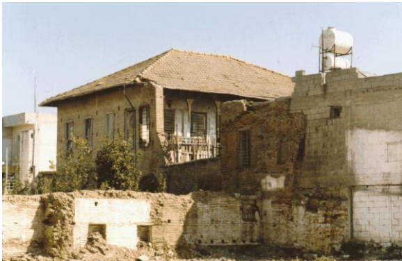
Bina 58 Tescilli (env.no:64) Bina depremden sonra kısmen kullanılmamaktadır.
