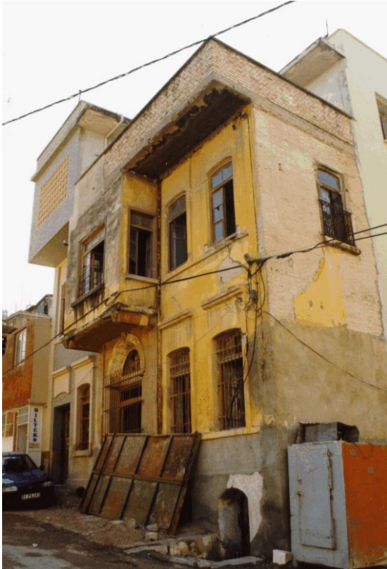
Bina 43 Tescilli (env.no:55) Bina depremden sonra kullanılmamaktadır.
