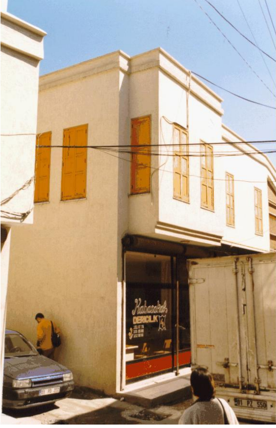
Bina 39 Tescilli (env.no: 134) Yapı kullanılmaktadır.
