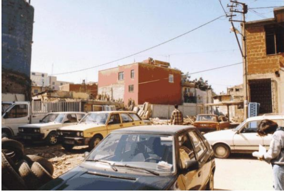
Bina 56 Tescilli (env.no:114) Bina depremde yıkılmıştır.
