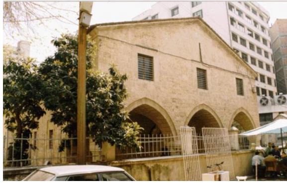
Bina 5 Tescilli (env.no:192) Adana Etnoğrafya Müzesi Yapı kullanılmaktadır.
