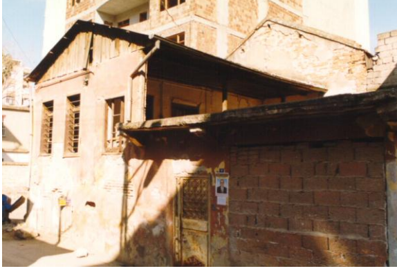
Bina 1 Konut kullanılmamaktadır.
