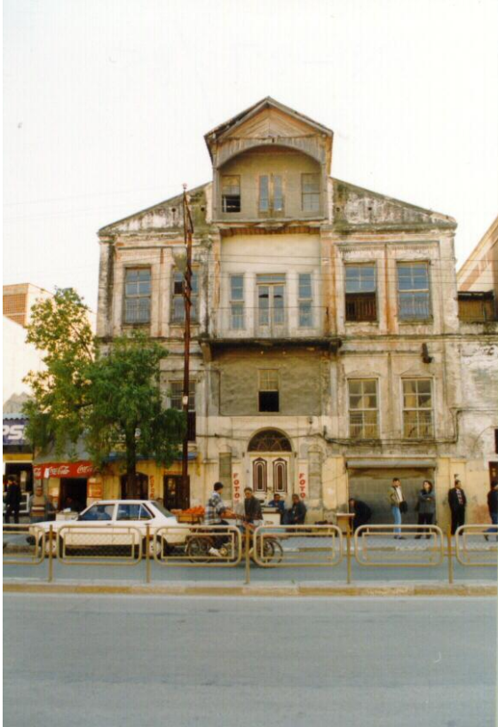
Bina 27 Tescilli (env.no: 85) Deprem sonrası konut kullanılmamaktadır.
