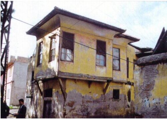
Bina 11 Env.no: 80 Deprem sonrası kurul kararı ile yıkım.
