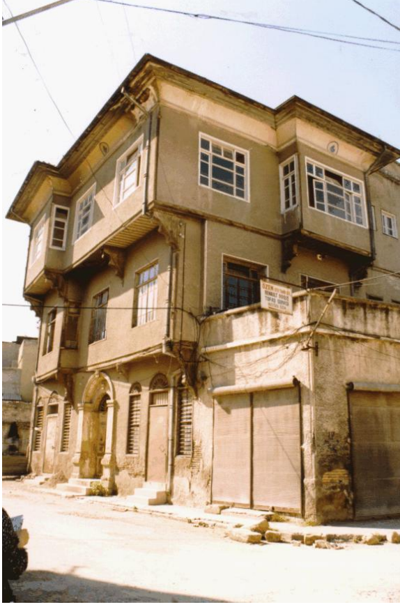
Bina 3 Tescilli (env.no:124) Deprem sonrası kullanılmamaktadır.
