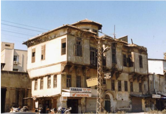
Bina 25 Tescilli (env.no:191) Yedi Sıra Ev Bina kullanılmamaktadır.
