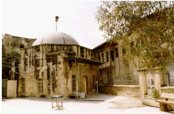
Bina 6 Tescilli (env. no: 232) Alemdar Cami Deprem sonrası cami kullanılmamaktadır.
